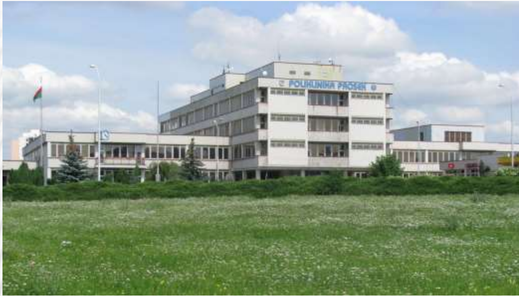
Budova polikliniky před rekonstrukcí - 2012
