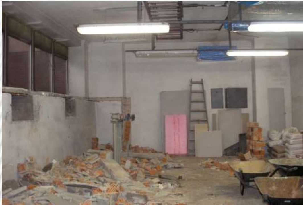
Rekonstrukce prostor strojovny VZT na pracoviště rehabilitace -2013
