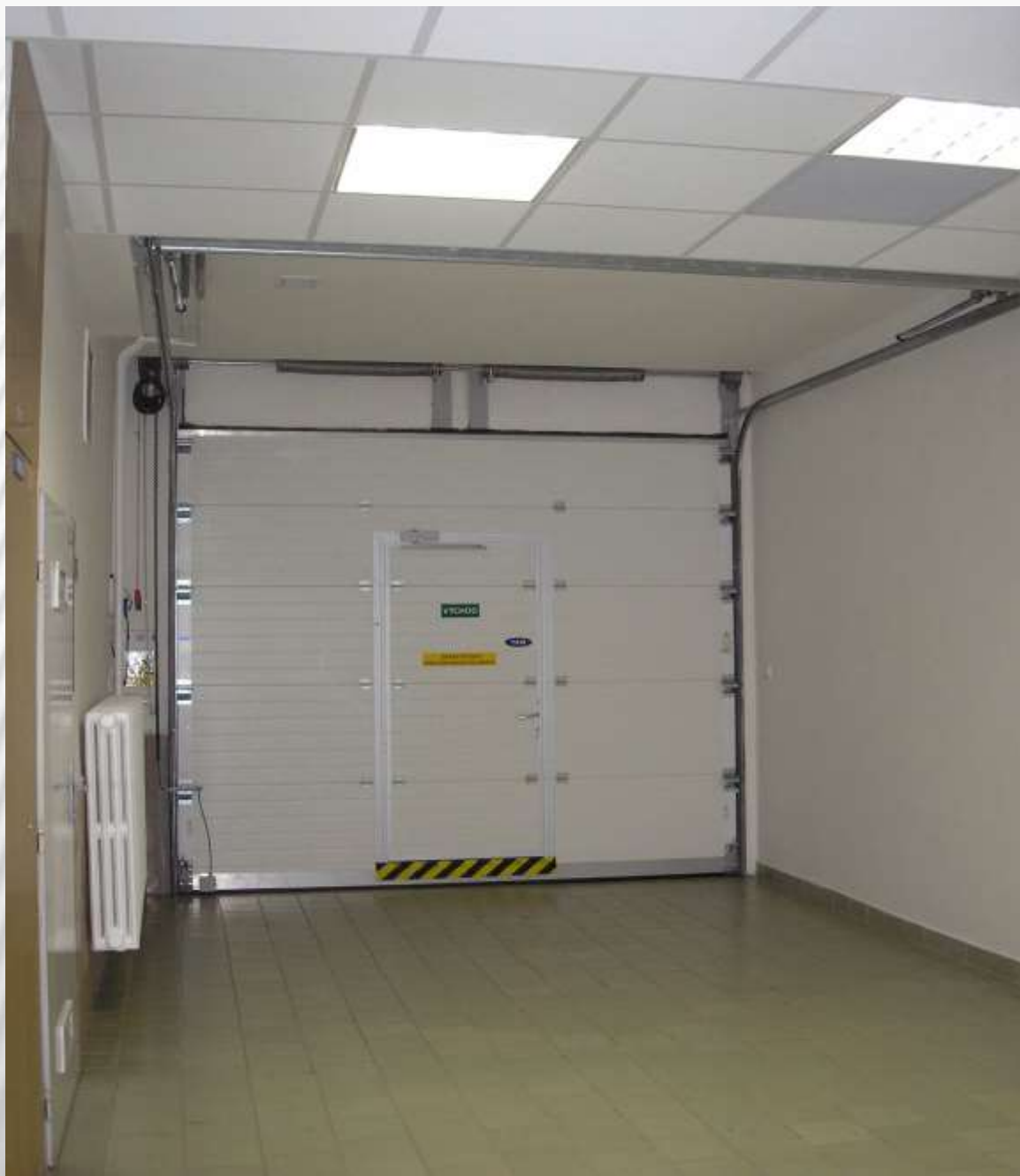
Rekonstrukce vstupu pro zásobování - 2014
